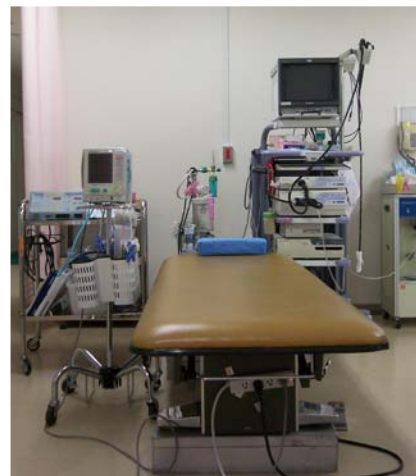
当院の内視鏡検査設備
